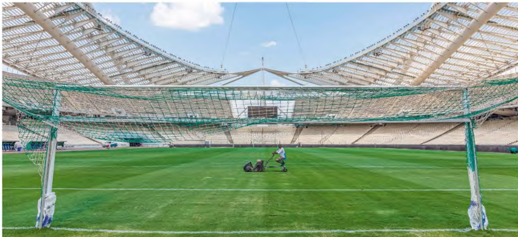
Εικοσι χρόνια μετά τους Αγώνες η λάμψη των πυρτεκνημάτων έχει σβήσει οριστικά πάνω από το ΟΑΚΑ. Αλλωστε, η ολυμπιακή αήλη είχε δώσει τη θέση της στην περιουσιολογία, πολύ πριν το εμβληματικό στέγαστρο Καλατράβα μπει «κνήμεν», χωρίς τα πολυκαριπνικά πάνελ, τα οποία αφαιρέθηκαν αφού κρίθηκε ότι έφραζε να αντικατασταθούν λόγω φθοράς.
